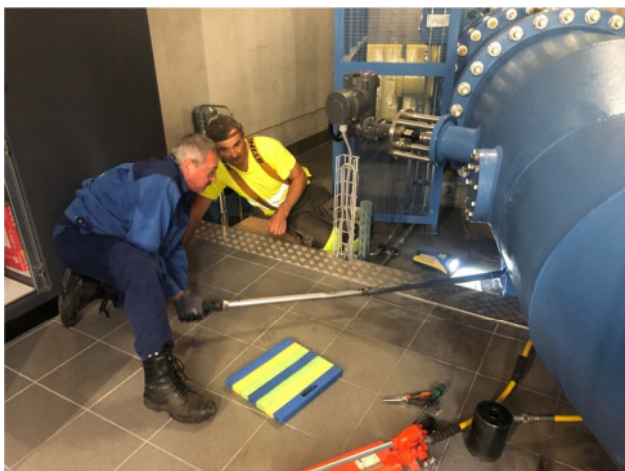
Bild: Turbineninspektion Endabnahme August 2022
